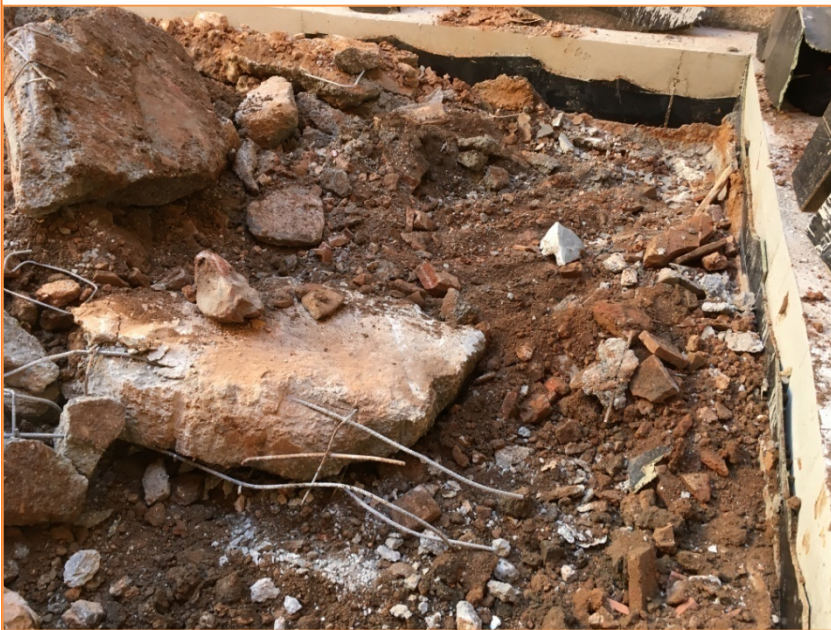
Foto 6. Treballs d'excavació del nivell UE 2 i enderroc muret guia.
