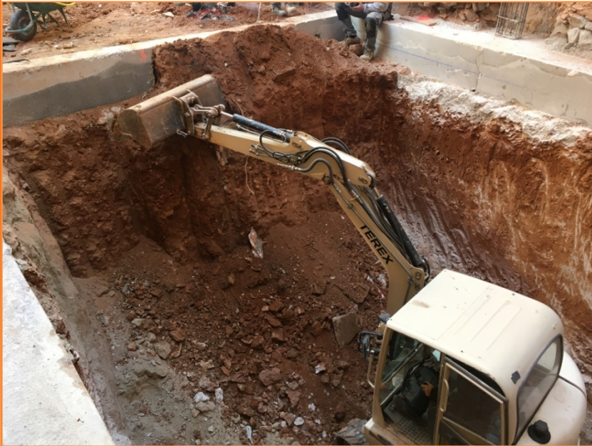
Foto 11. Vista del solar un cop fet els rebaixos generals.
