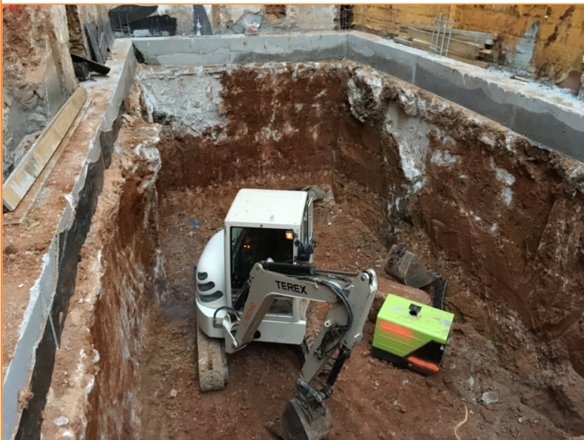
Foto 10. Vista del solar un cop fet els rebaixos generals.
