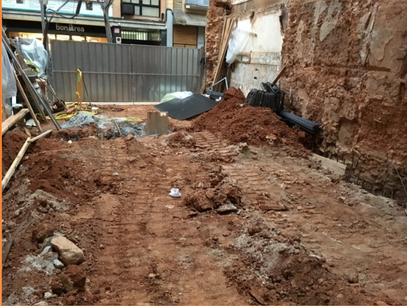
Foto 1. Vista des de l'est del solar en moment d'inici del control.
