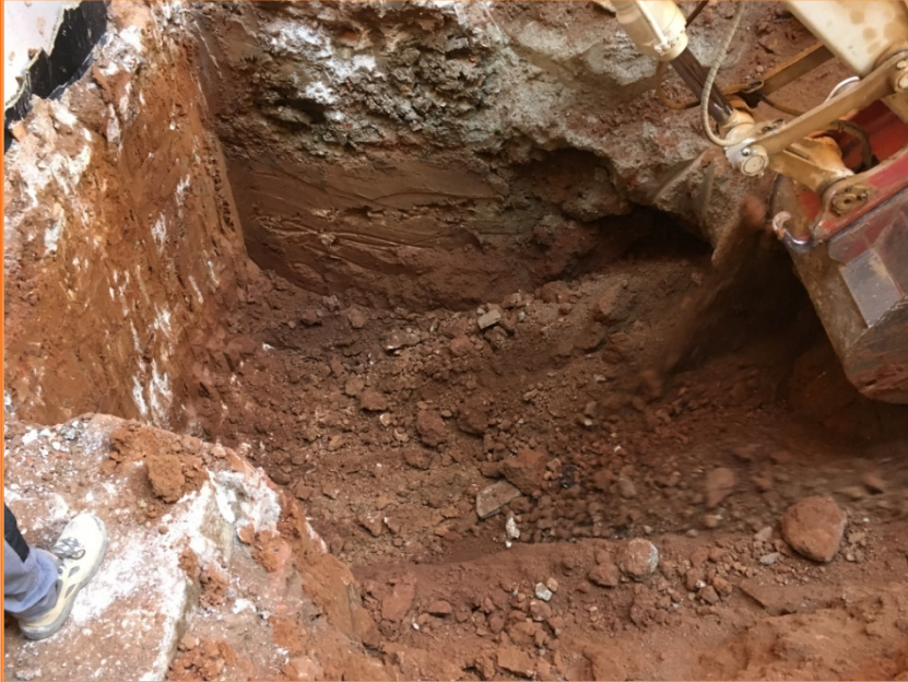
Foto 7. Treballs d'excavació del nivell UE 2.
