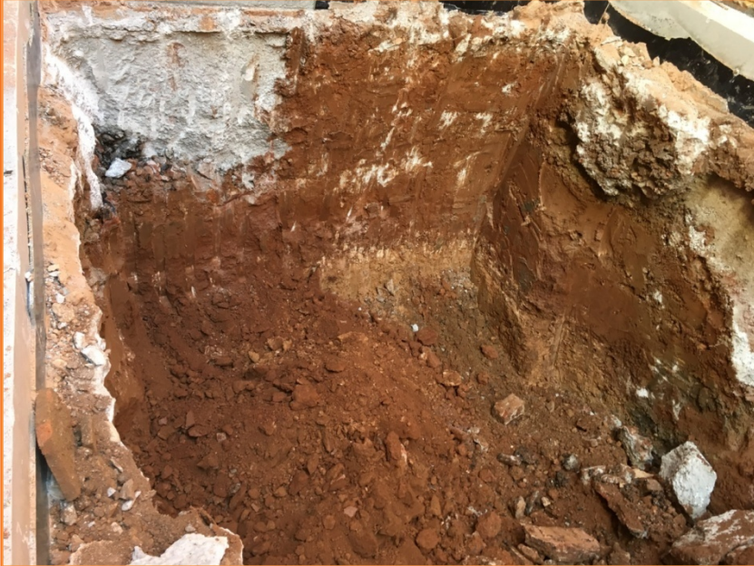
Foto 9. Vista del solar un cop fet els rebaixos generals.
