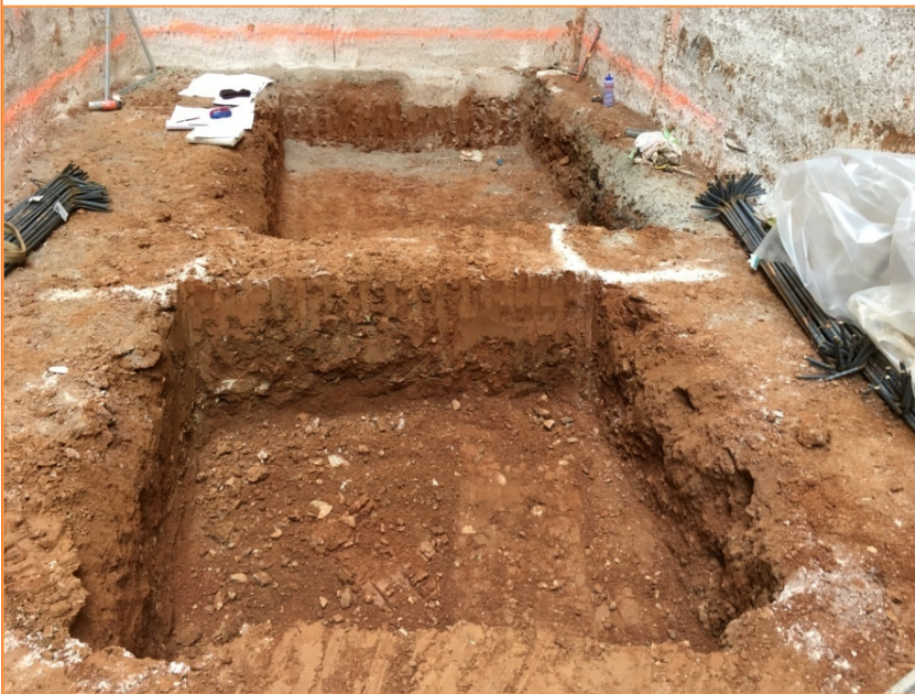
Foto 12. Vista dels pous de l'ascensor i pilar central.
