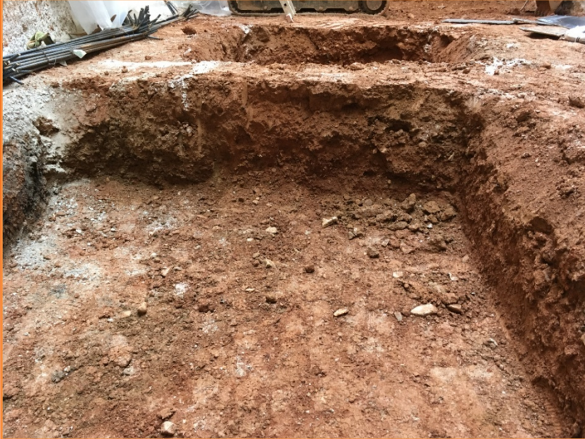
Foto 13. Vista dels pous de l'ascensor i pilar central.
