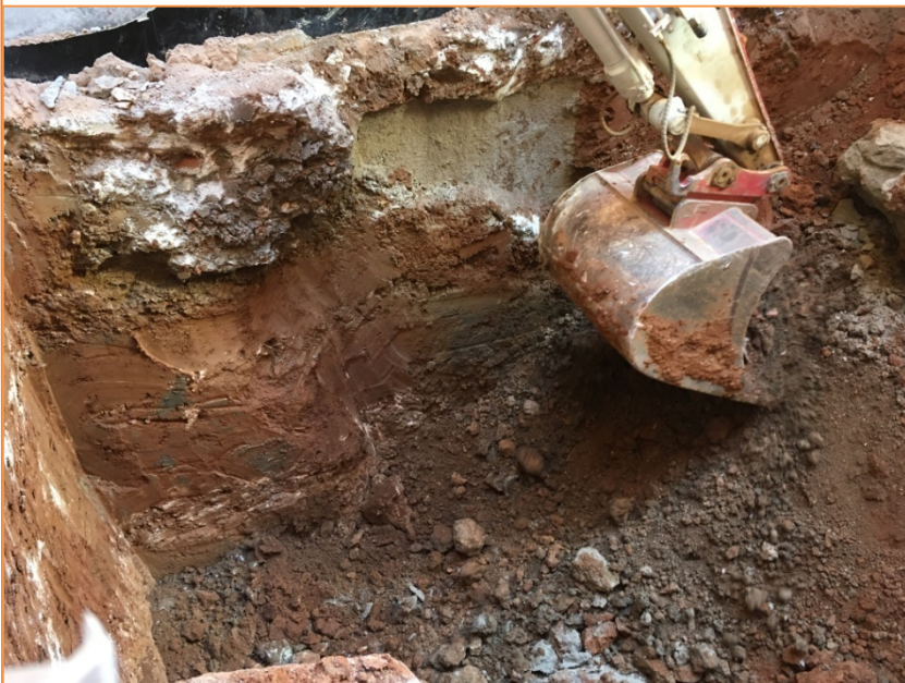
Foto 8. Treballs d'excavació del nivell UE 2.
