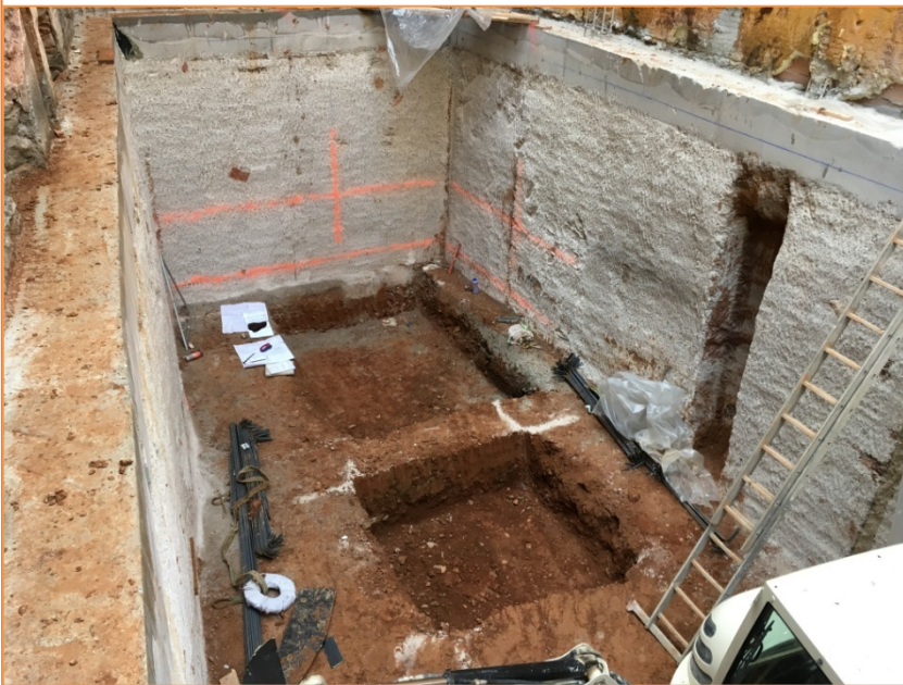
Foto 14. Vista general del solar un cop acabat el control dels rebaixos.
