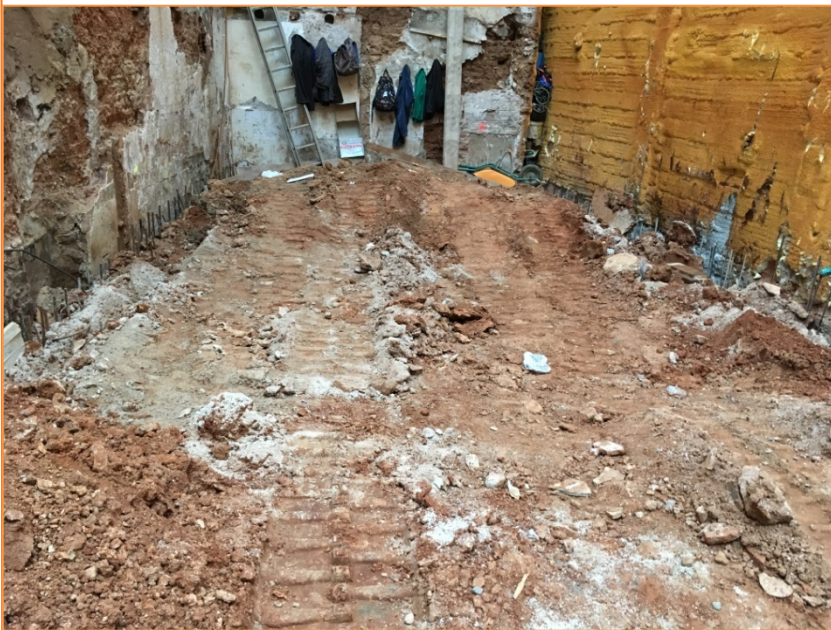
Foto 2. Vista des de l'oest del solar en moment d'inici del control.
