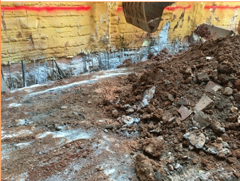
Foto 4. Treballs d'excavació del nivell UE 1.
